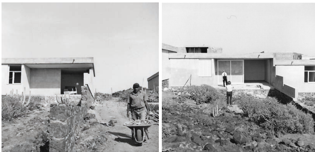
Afbeelding 8: (Links) Alvarez, A., (z.d.). Constructiewerken op het Bellavistacomplex. [Foto]. Opgehaald van http://www.panoramio.com/user/5462806?show=all op 12 december 2015.
